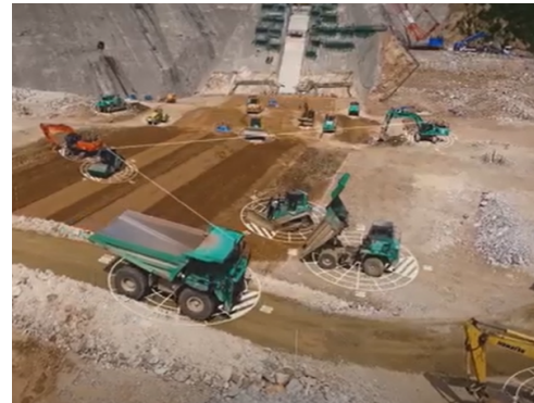
Figure 18 : Système A 4 CSEL (Automated / Autonomous / Advanced / Accelerated Construction System), L'objectif est de répondre à la pénurie de main-d'œuvre, améliorer la sécurité, et transformer un chantier en véritable "usine à ciel ouvert".
